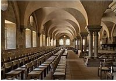
Laienrefektorium: romanische Doppelsäule und Kreuzgratgewölbe
